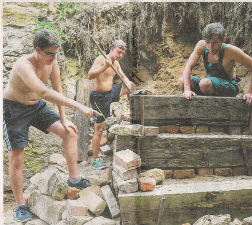
Praktische Erfahrungen: Davon profitieren die Gymnasiasten Alexander Schmidt, Martin Demmrich und Thomas Wilhelm (v.l.) beim Bau der Treppe neben der sanierten Burgmauer.
